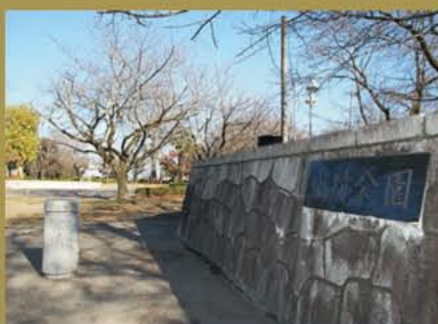
結城城跡 結城市内に残る結城城跡は現在は公園となっている。当時の城を思い起こさせる建築物はないが、公園前にある内堀跡が城の面影を感じさせてくれる
